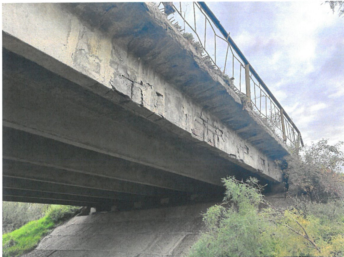
Fotografia 12. Suprastructura ( deschidere nr.5): Grindă cu infiltrații masive, cu betonul degradat, cu armatură neprotejată, afectată puternic de coroziune, vegetație pe sferturile de con.
