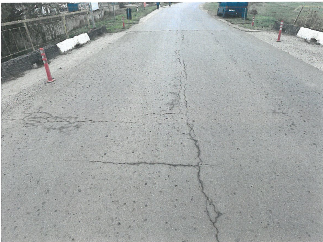
Fotografia 5. Calea podului: îmbrăcămintă asfaltică fisurată.
