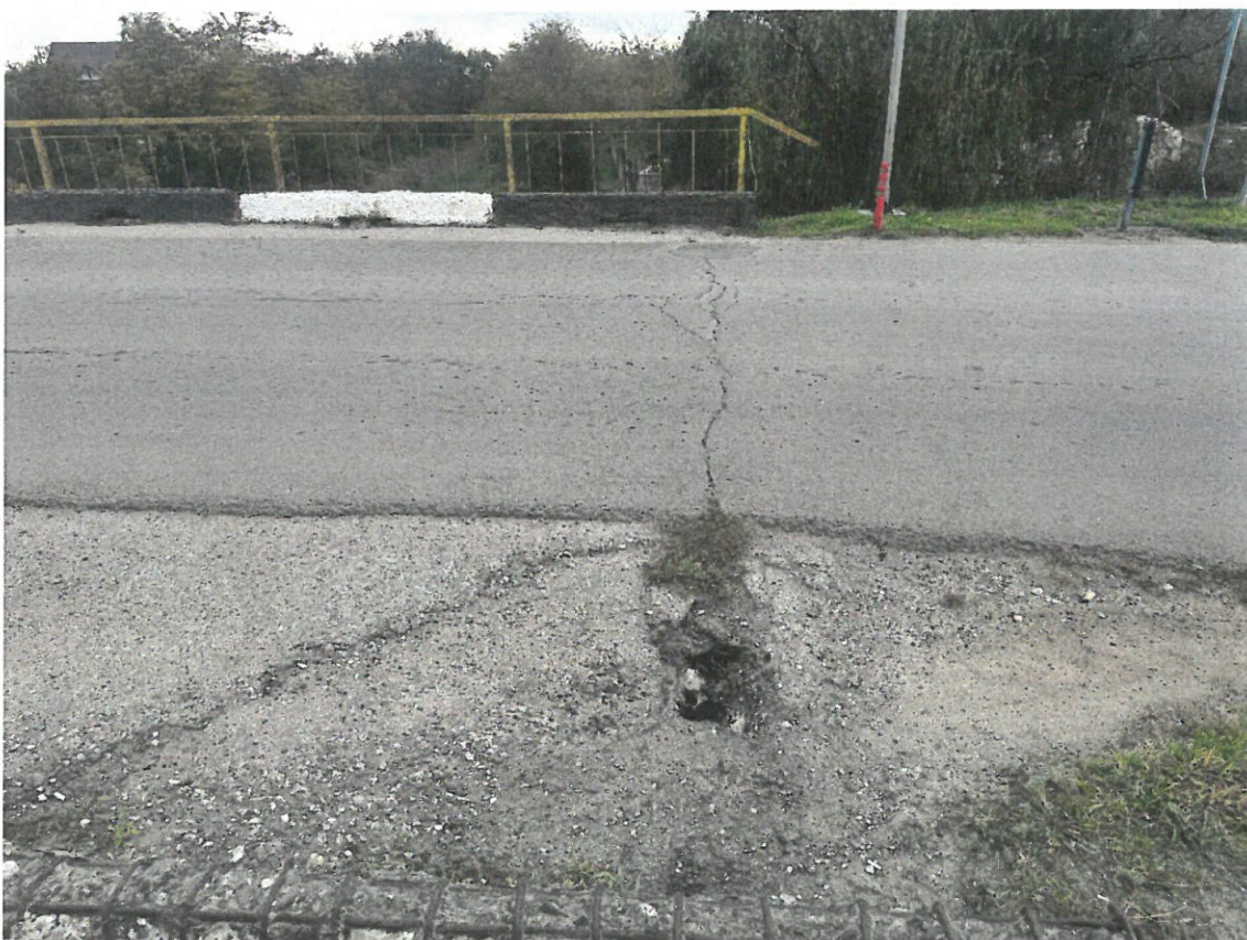
Fotografia 6. Detaliu cale (culeei nr.2): Elemente de acoperire a rostului degradate, îmbrăcămintă asfaltică fisurată.
