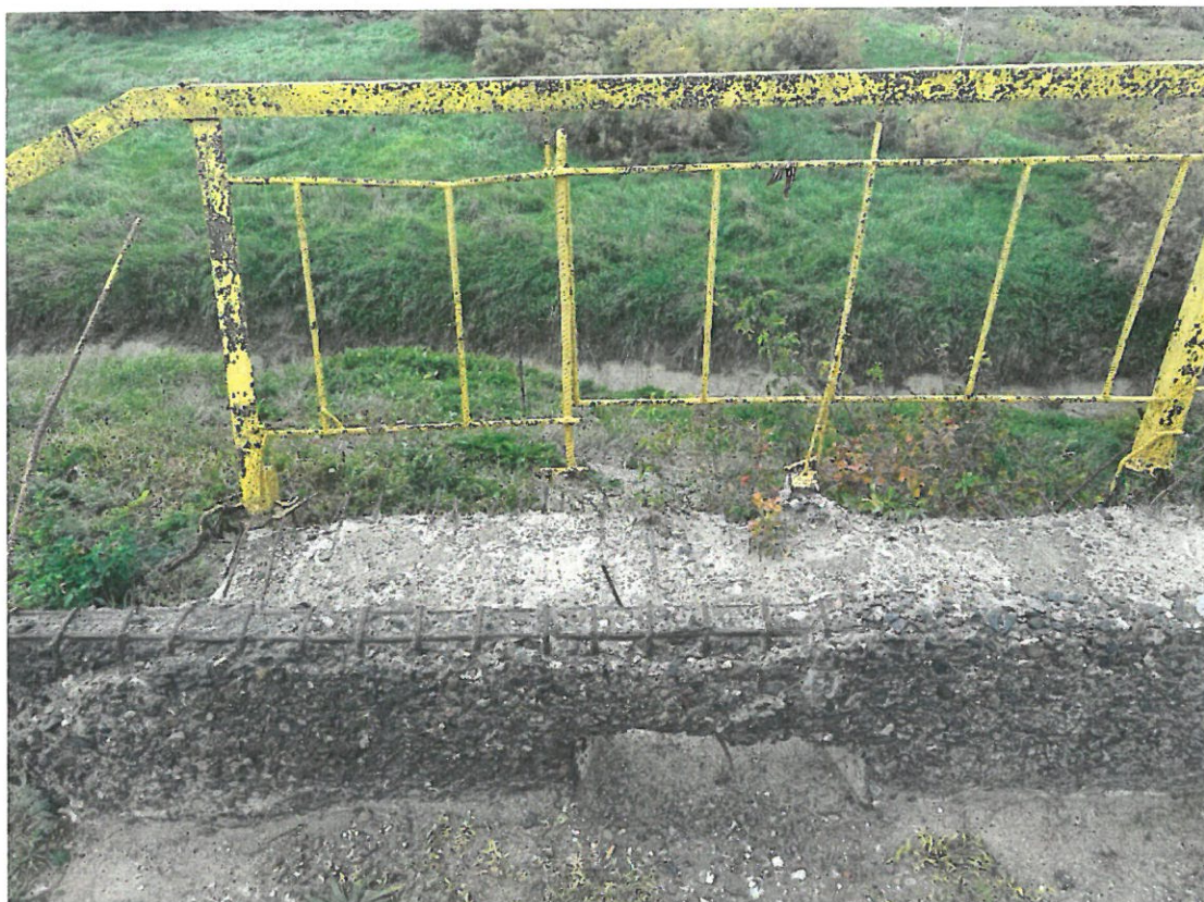
Fotografia 9. Detaliu trotuar: Beton degradat prin coroziune, cu armatură neprotejată, afectată puternic de coroziune, parapet degradat, fixare necorespunzătoare a parapetului.
