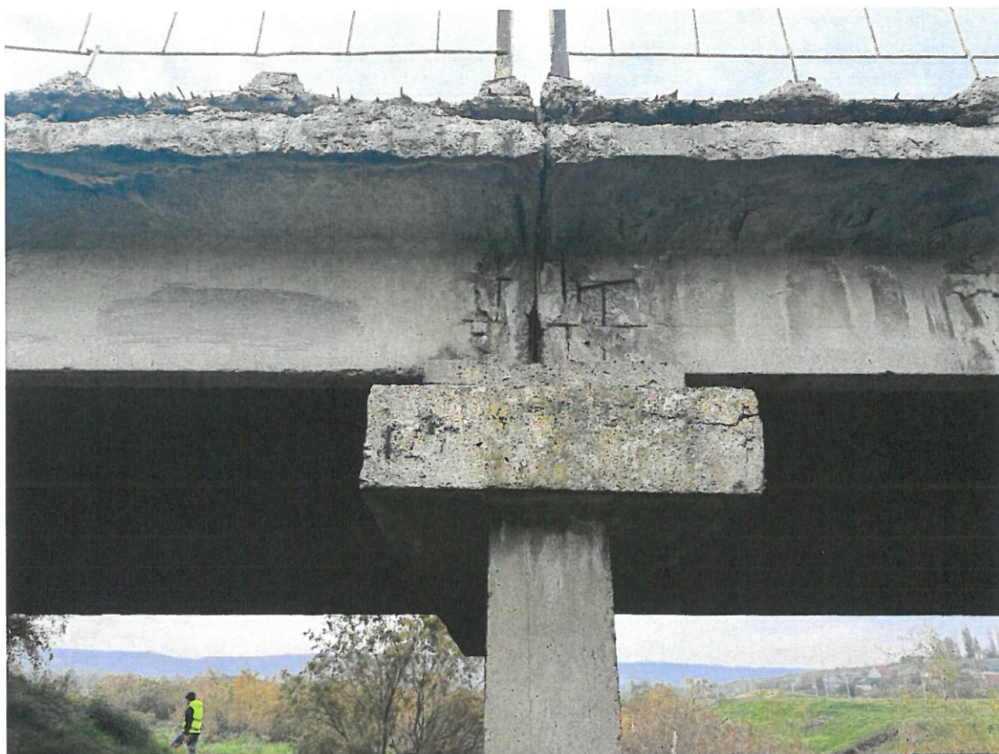
Fotografia 19. Detaliu de rezemare: (pila nr.4, amonte): Rost de dilatație blocat, grinzi cu betonul fisurat, coroziunea armaturii.
