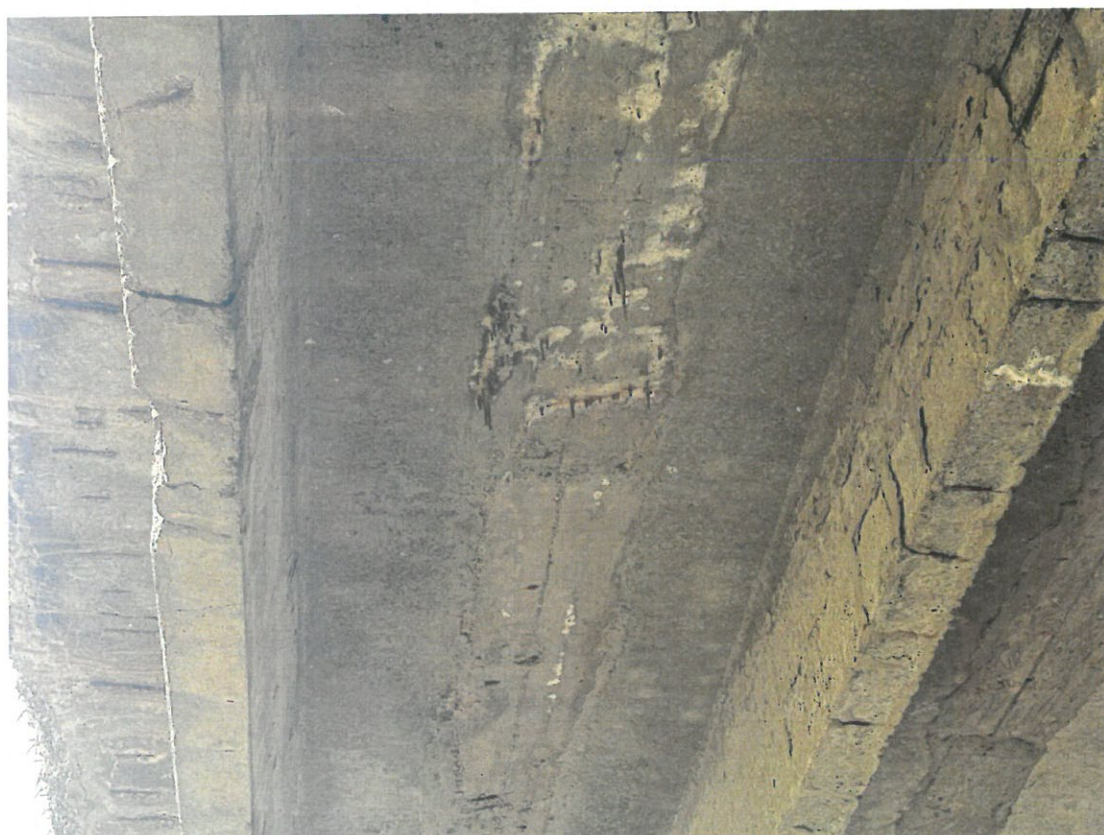
Fotografia 16. Suprastructura (detaliu intrados): Grinzi cu infiltrații masive, eflorescențe, stalactite, degradare prin carbonatare a betonului, acoperire necorespunzătoare a armaturii, coroziunea armaturii.
