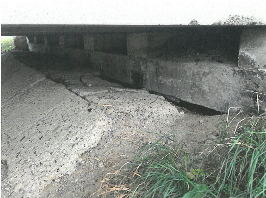
Fotografia 23. Vedere culee nr.2. Degradarea betonului de protecție a taluzului, vegetație.
