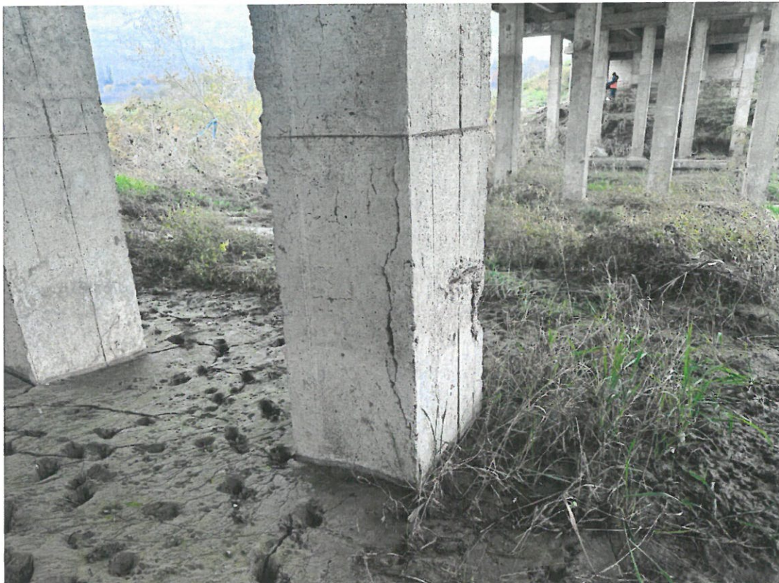
Fotografia 25. Detaliu stâlpi: Fisurarea betonului, desprinderi de beton, cu armatură neprotejată, coroziunea armaturii.
