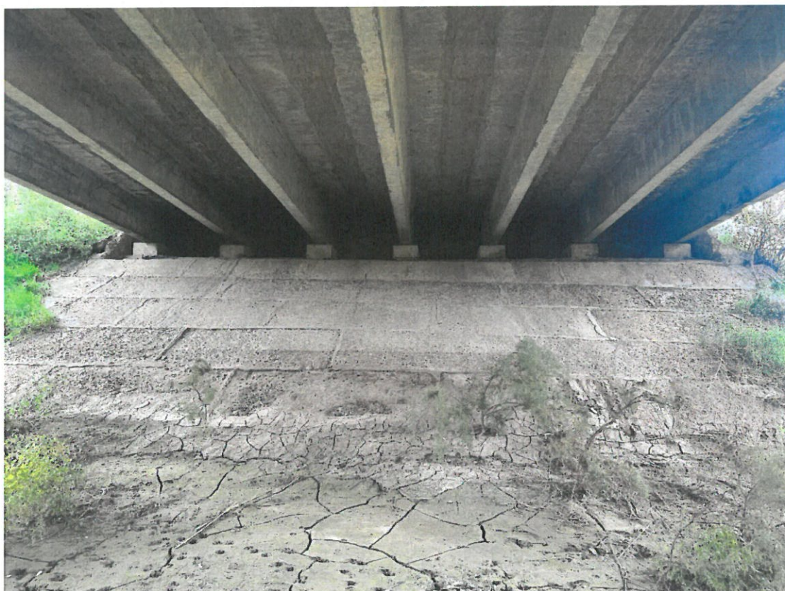
Fotografia 22. Vedere culee nr.2. Degradarea prin coroziune a betonului de protecție a taluzului, vegetație .
