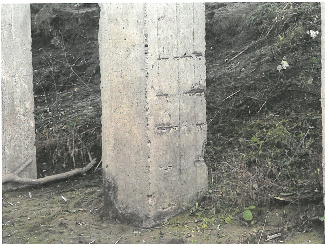
Fotografia 27. Detaliu stâlpi: Strat de acoperire insuficient, desprinderi de beton, cu armatură neprotejată, coroziunea armaturii.
