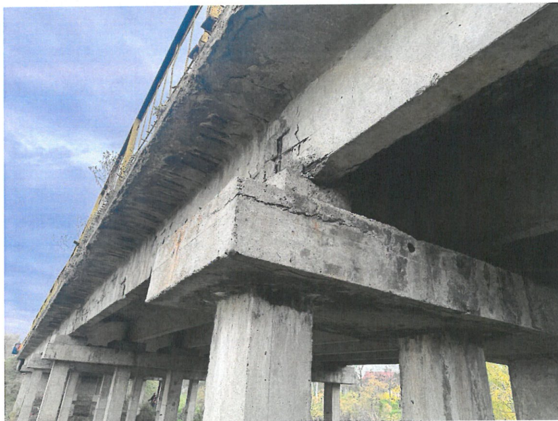
Fotografia 18. Infrastructura (detaliu de rezemare): Infiltrații, coroziunea armaturii, pete de rugină/fisuri pe direcția acestora, beton degradat, cu armatură descoperită.
