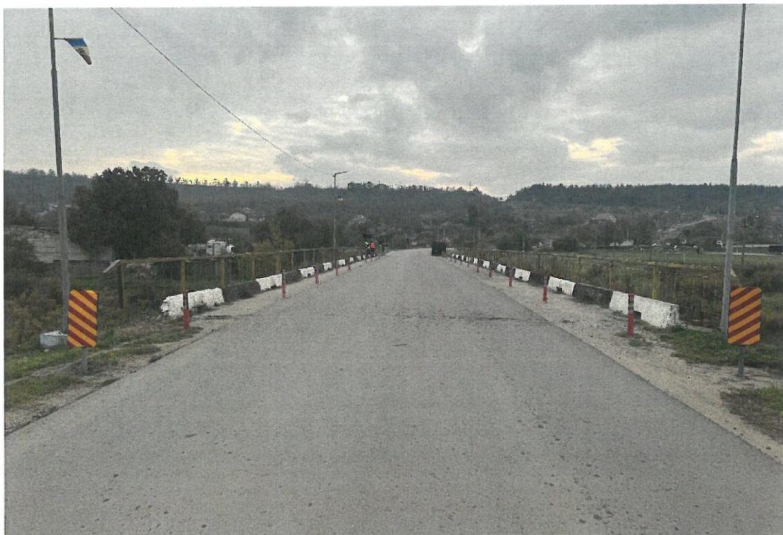
Fotografia 3. Calea podului: Lățime necorespunzătoare a căii și trotuarelor, lipsa parapetului de siguranță a traficului, acumulări de material solid pe cale.
