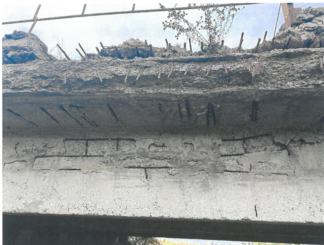
Fotografia 20. Detaliu suprastructură (deschiderea nr.5, amonte): Grinda și consola trotuarului cu beton degradat, cu armatura neprotejată, afectată puternic de coroziune.
