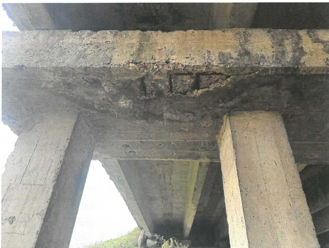
Fotografia 24. Fragment riglă (pila nr.1): Infiltrații, pete de rugină, degradarea betonului de acoperire, coroziunea armaturii.
