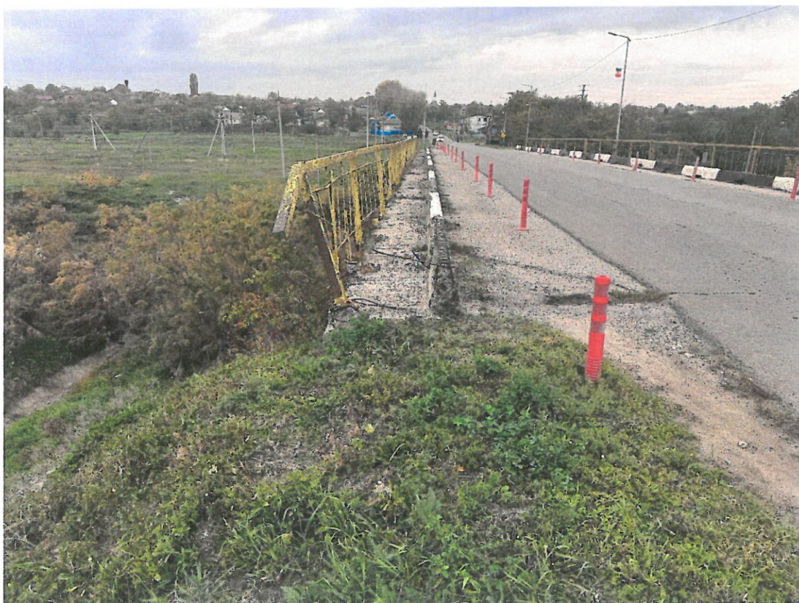
Fotografia 8. Detaliu trotuar (dreapta): Racordare necorespunzătoare a trotuarului cu terasamentul rampei de acces, acces dificil pe trotuarul podului, parapet degradat, fixare necorespunzătoare a parapetului.
