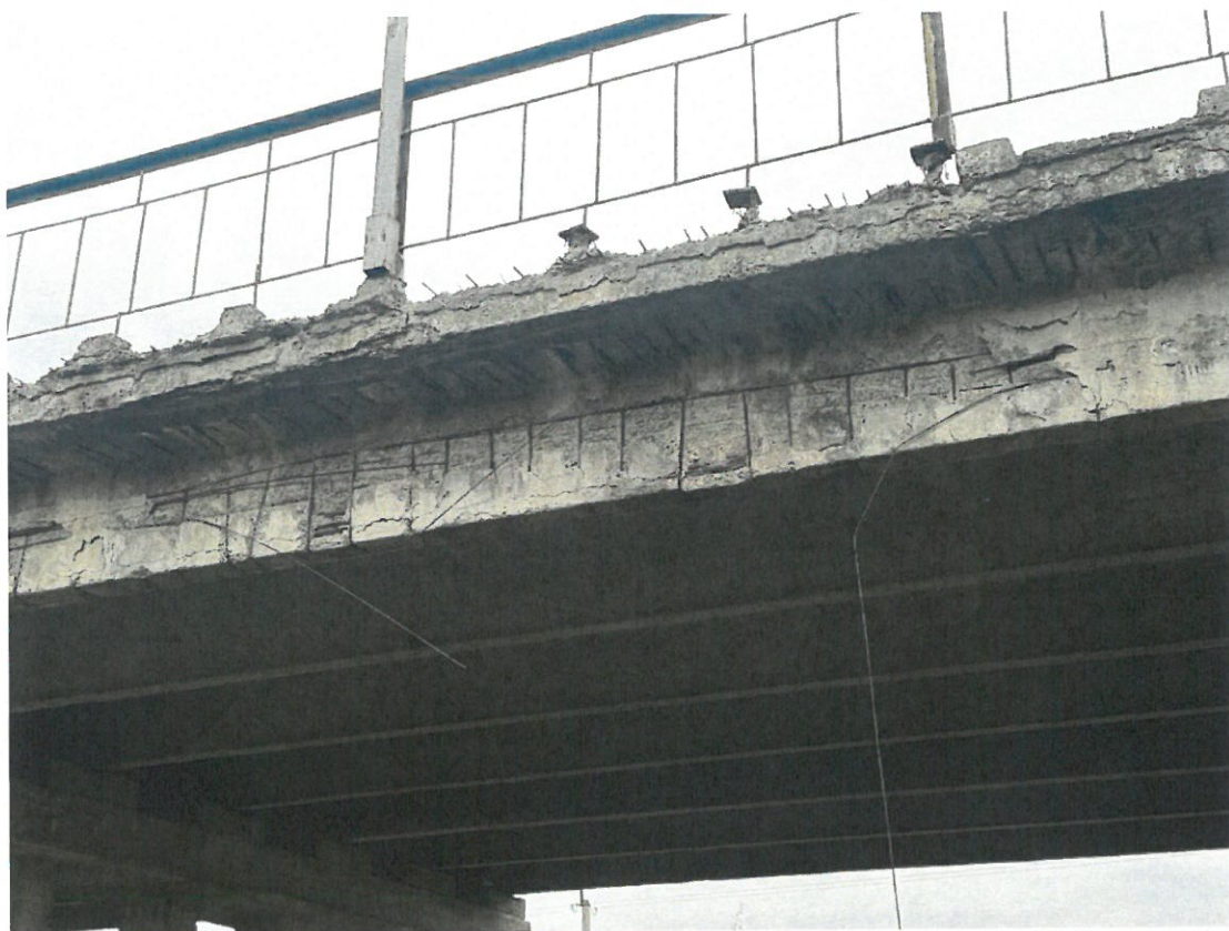
Fotografia 15. Suprastructura: Grindă cu beton degradat, cu armatură neprotejată, afectată puternic de coroziune, parapet pietonal degradat, cu prindere necorespunzătoare în zona de contact cu trotuarul.
