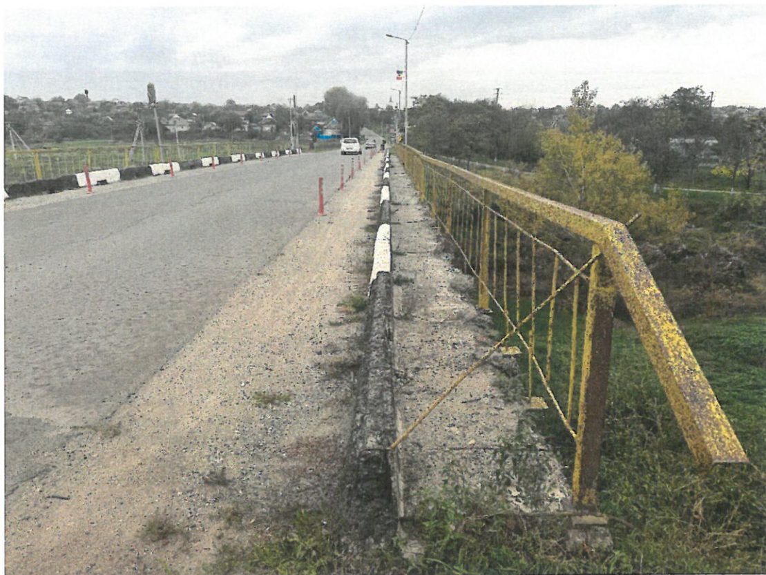
Fotografia 7. Detaliu trotuar (stânga): Beton degradat, coroziunea armaturii, parapet degradat cu fixare necorespunzătoare, vegetație la nivelul căii.
