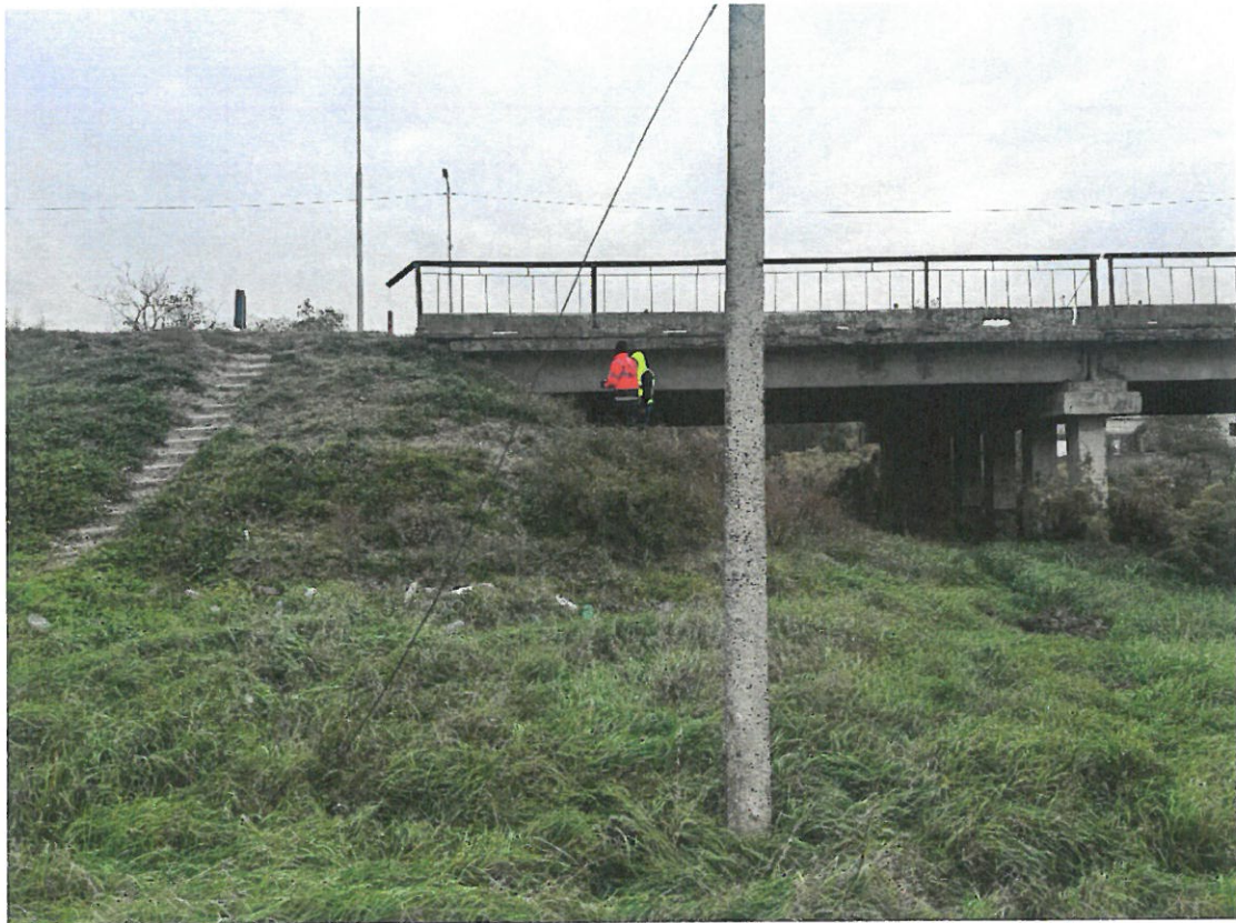
Fotografia 11. Vedere racordare pod (culee nr.1): Degradarea scărilor, lipsa balustradei, prezența materialului solid și a vegetației pe sferturile de con.
