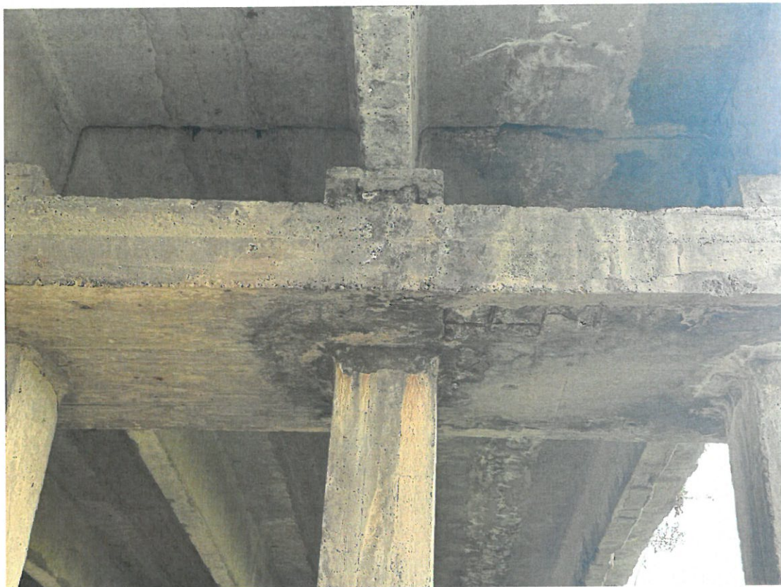
Fotografia 17. Infrastructura (detaliu de rezemare): Betonul riglei cu infiltrații, eflorescențe, armatură descoperită, coroziunea armaturii, degradarea cuzinetului.
