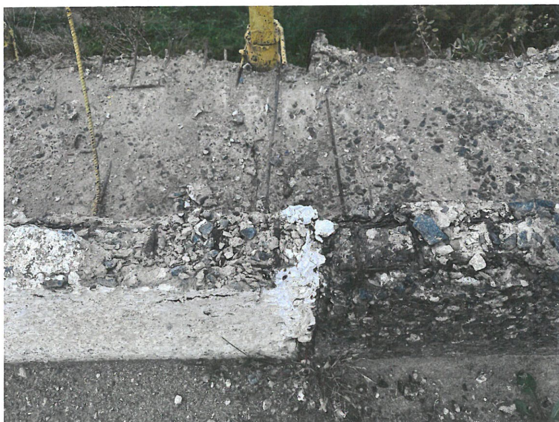
Fotografia 10. Detaliu bordură: Beton degradat prin coroziune, cu armatură neprotejată afectată puternic de coroziune.
