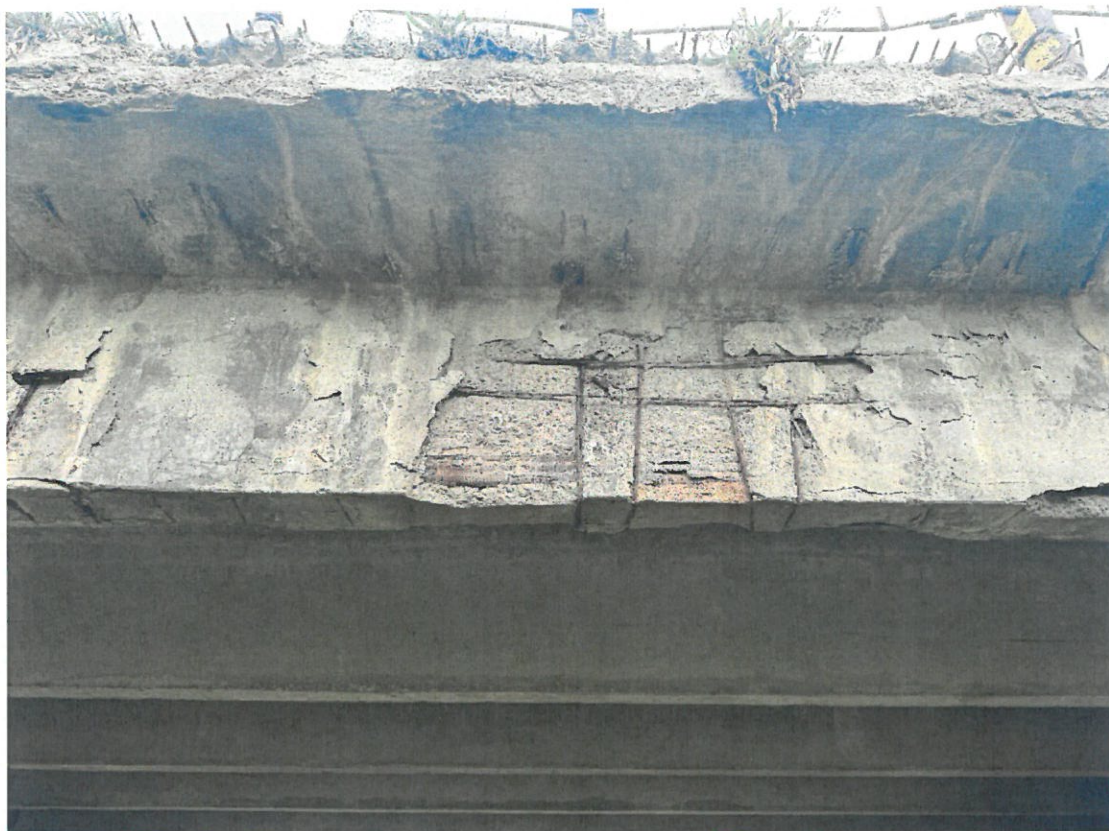
Fotografia 13. Suprastructura (detaliu grindă marginală): Infiltrații masive, beton degradat, armatură neprotejată, afectată puternic de coroziune, poziționare necorespunzătoare a armaturii, prezența vegetației pe suprastructură.
