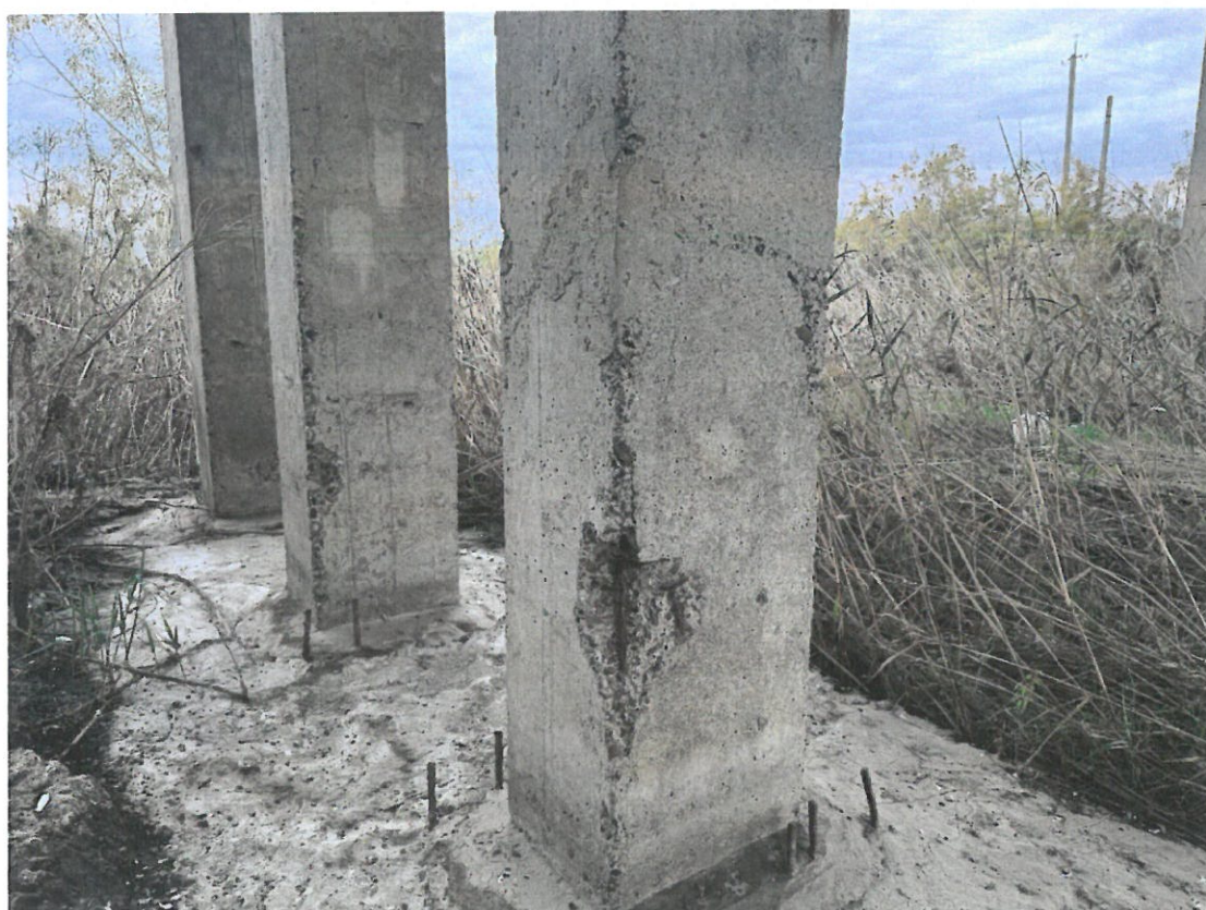
Fotografia 26. Detaliu stâlpi: Defecta de suprafață, desprinderi de beton, cu armatură neprotejată, coroziunea armaturii.
