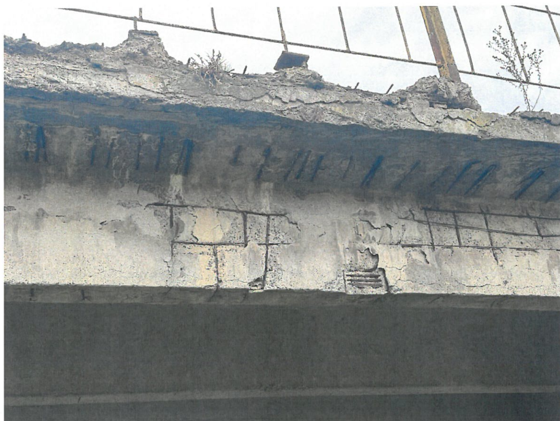
Fotografia 14. Detaliu suprastructură: grindă marginală cu infiltrații masive, betonul degradat, armatură neprotejată afectată puternic de coroziune, prezența vegetației pe suprastructură.
