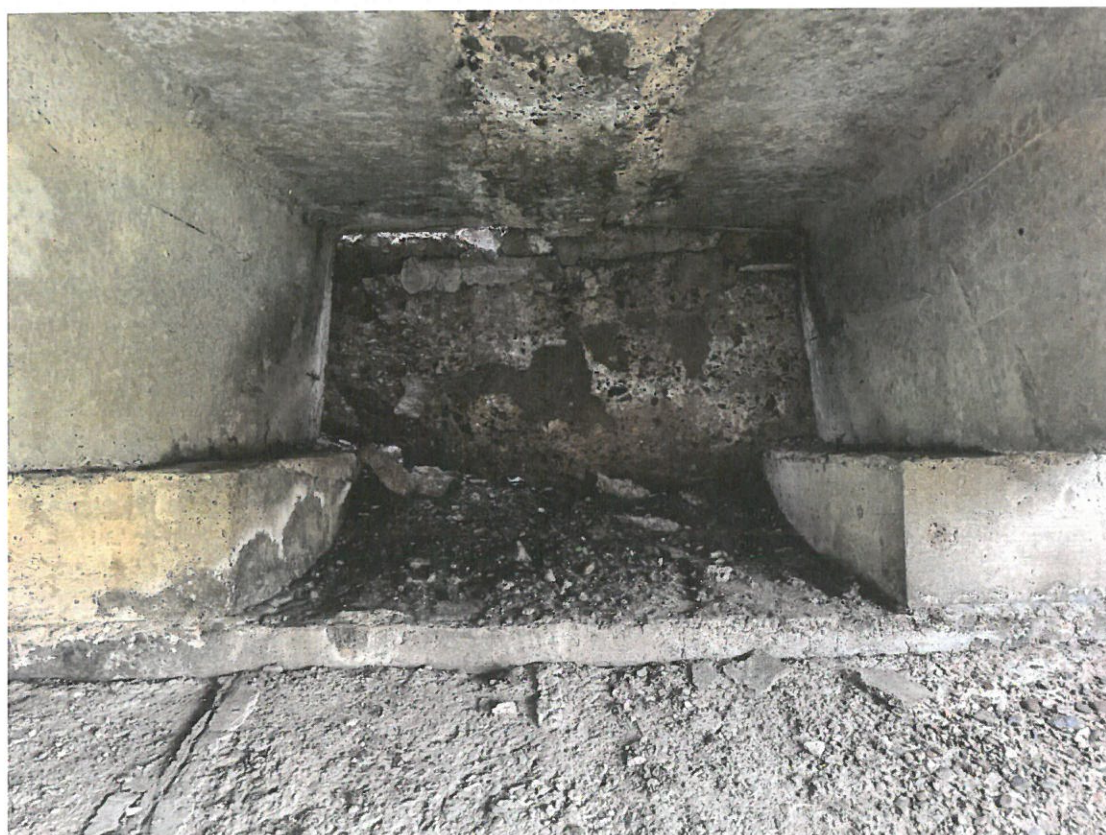
Fotografia 28. Detaliu rezemare pe culee. Infiltrații prin rostul degradat, degradarea betonului, coroziune armaturii, rezemare necorespunzătoare, grinzi înglobate în praf și murdărie.
