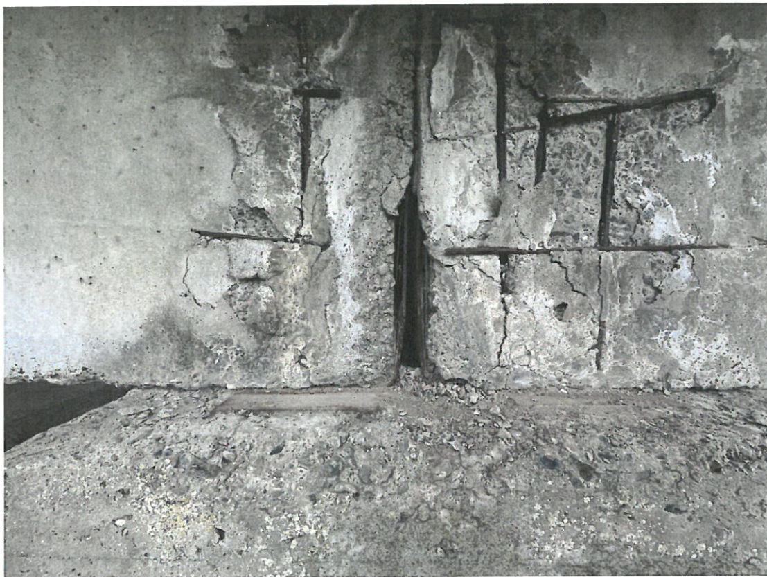
Fotografia 21. Detaliu rezemare: Rezemare necorespunzător a grinzilor, lipsa aparatelor de reazem, rost de dilatare blocat, betonul grinzilor degradat, armatură puternic afectată de coroziune.
